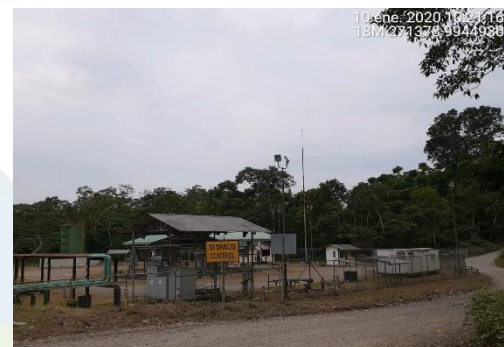
FOTOGRAFIA N° 6: Instalacion Petrolera Campo Payamino
