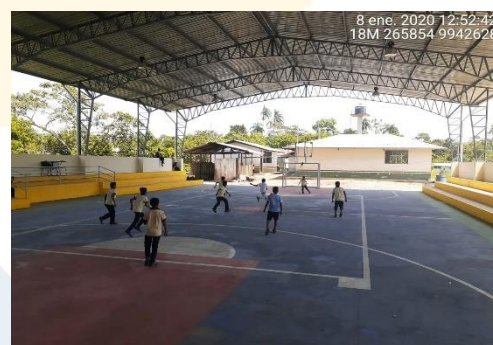
FOTOGRAFIA Nº 18: Cancha cubierta de la Comuna Alto Manduro
